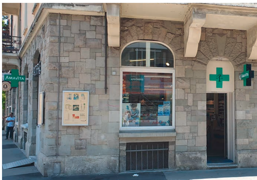
Steinfassade Geschäftshaus an der Kernstrasse in Zürich.
